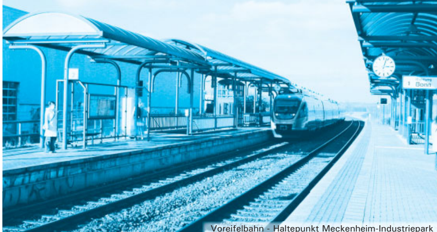
Voreifelbahn - Haltepunkt Meckenheim-Industriepark
