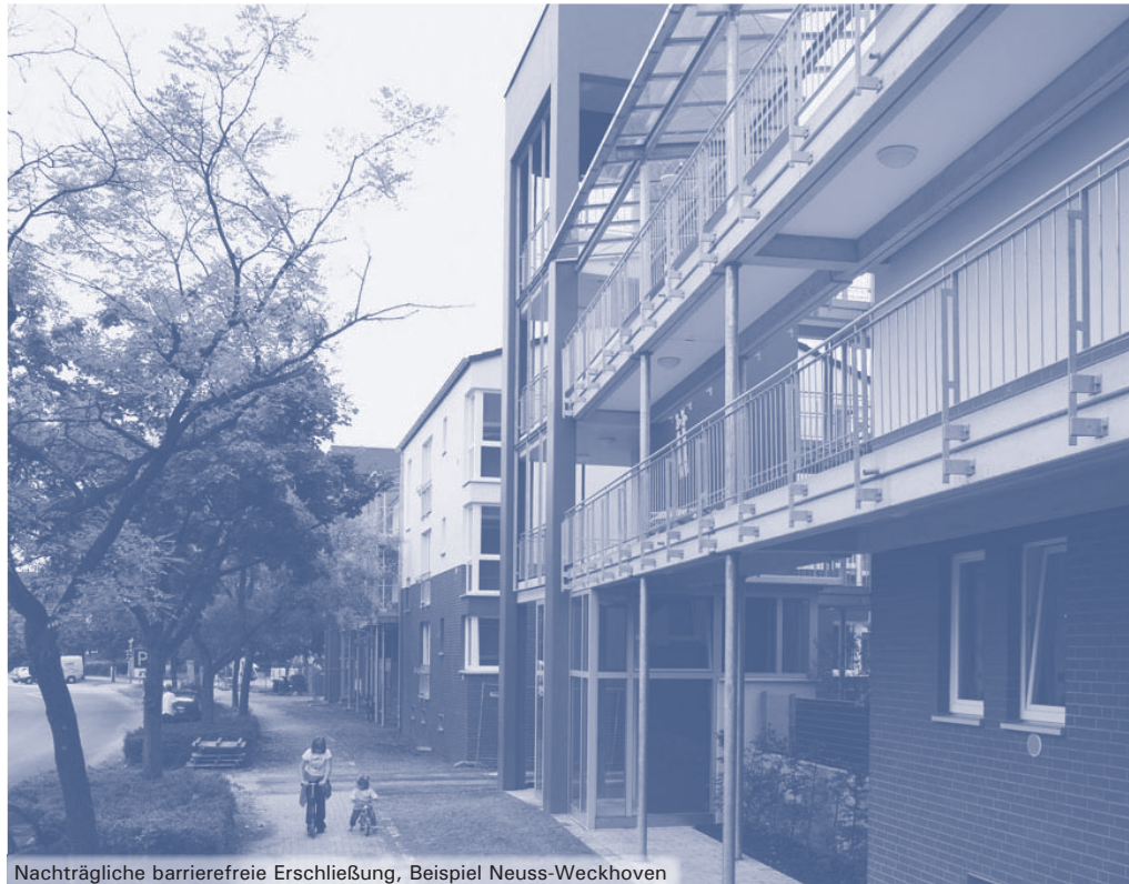
Nachträgliche barrierefreie Erschließung, Beispiel Neuss-Weckhoven
