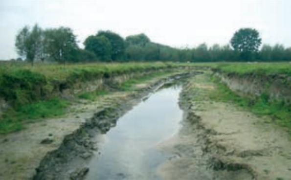
Nachahmenswert ist diese Vorgehensweise jedoch nur, wenn Sedimentationseinrichtungen wie Sandfänge installiert werden, die verhindern, dass das Niveau der Sohle im Bereich des weiteren Bachverlaufes ver-
