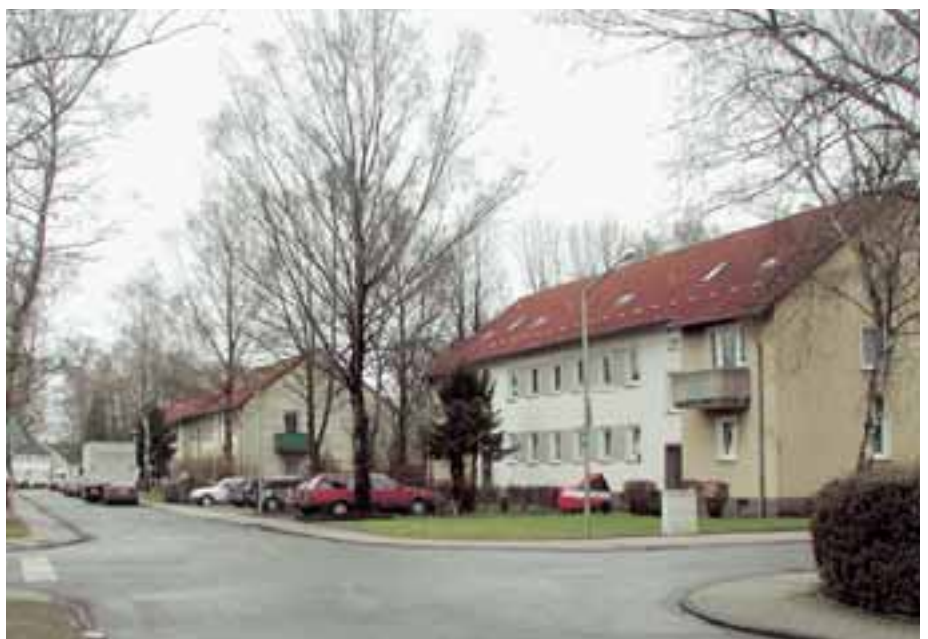
Abb. 14: Haupterschließungsstraße in der Otto-Lenz-Siedlung
