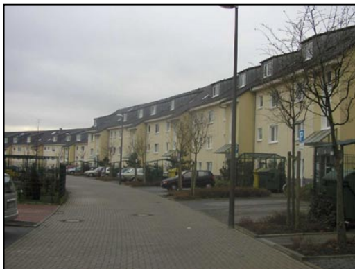
Abb. 30: Somborner Höh: Eingangssituation
