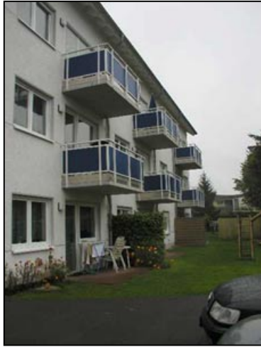
Abb. 68: Schillerstraße 4a: Rückseite
