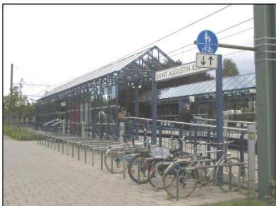
Abb. 59: Radabstellanlage am Stadtbahnhaltepunkt
