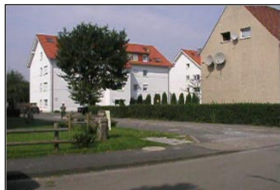
Abb. 67: Blick in die Schillerstraße
