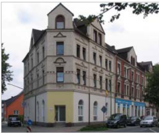
Das Gebäude hat trotz der Veränderungen im Erdgeschossbereich noch seine Wirkung als Eckgebäude im Straßenraum der Ewaldstraße erhalten.
