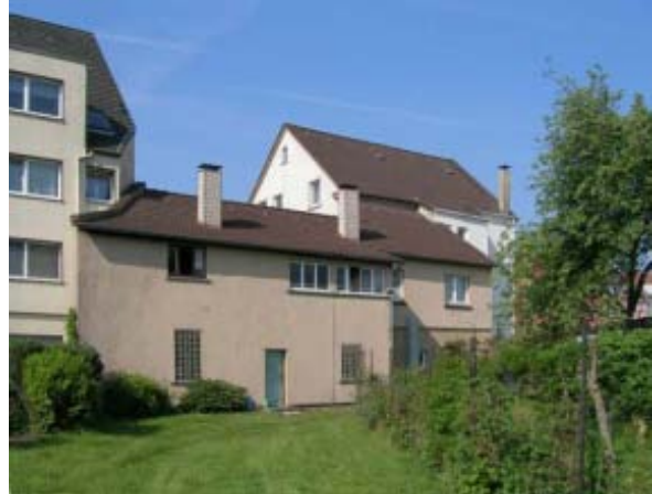
Die Rückseite des Nebengebäudes ist ebenfalls in der Anordnung und Größe der Öffnungen stark überformt und gänzlich ohne Gliederungs- oder Gestaltungselemente verputzt.
