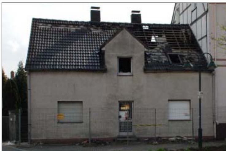
Das ausgebrannte Gebäude Ende 2008
