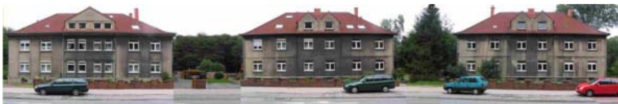
Fotografische Abwicklung der Gebäude der Ewaldstraße 249 bis 253, Bestand 2007
