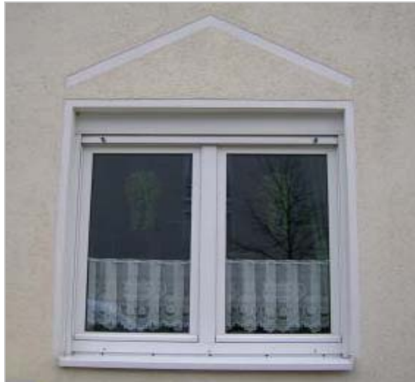
Ewaldstraße 127, Einzelfenster im EG
