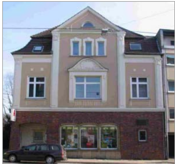
Ewaldstraße 93 (errichtet um 1906)
