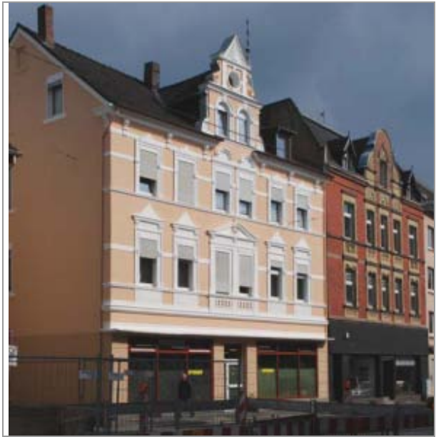
Bestand nach der Restaurierung 2008
