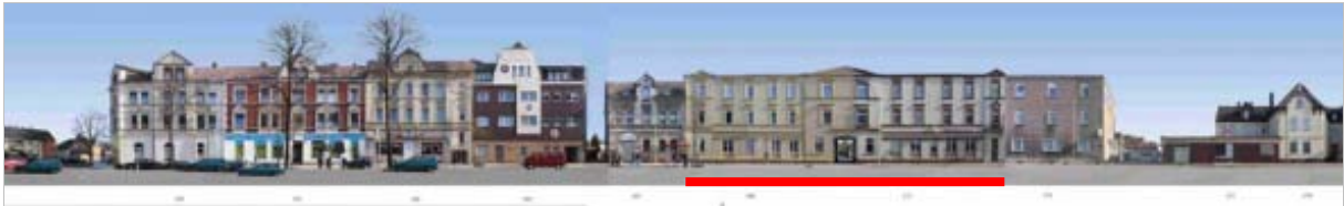
Die fotografische Abwicklung zeigt das Gebäudeensemble Nr. 157 bis 177 auf der Ostseite der Ewaldstraße mit der überwiegend noch überkommenen Bausubstanz aus der Jahrhundertwende von 1890 bis 1905.
