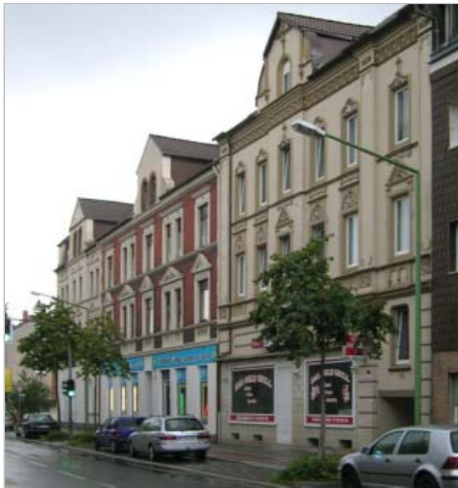
In der Abfolge der Bebauung hebt sich die Fassade des Gebäudes Nr.161 besonders durch die Ziegelfassade hervor.
