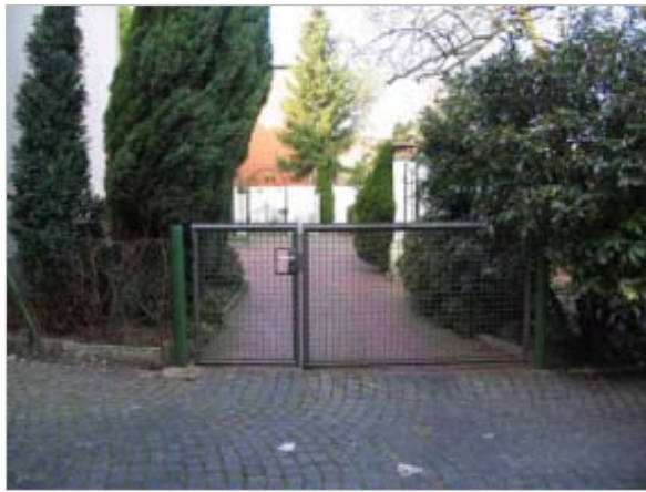
Die nördliche Eingrenzung besteht aus einer üppigen Bepflanzung und einem Maschendrahtzaun mit Toranlage zur Erschließung der Hof- und Gartenflächen Ewaldstraße Nr. 69 und Nr. 71.
