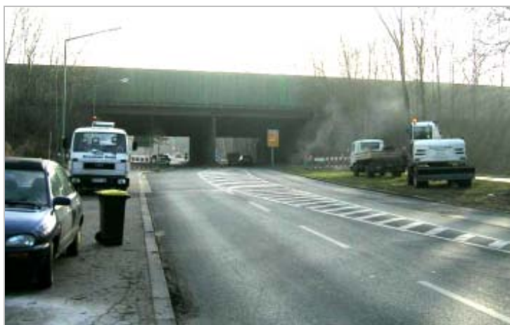
Die Autobahnbrücke der A2 bildet nicht nur optisch eine Barriere zu der südlich gelegenen Zeche Ewald.
