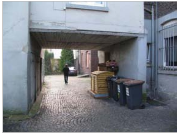
Nach Süden erfolgt die Erschließung des hinteren Grundstücksbereiches der Ewaldstraße Nr. 75 über eine Durchfahrt unter dem Verbindungsbaukörper zwischen Vorder- und Hinterhaus.
