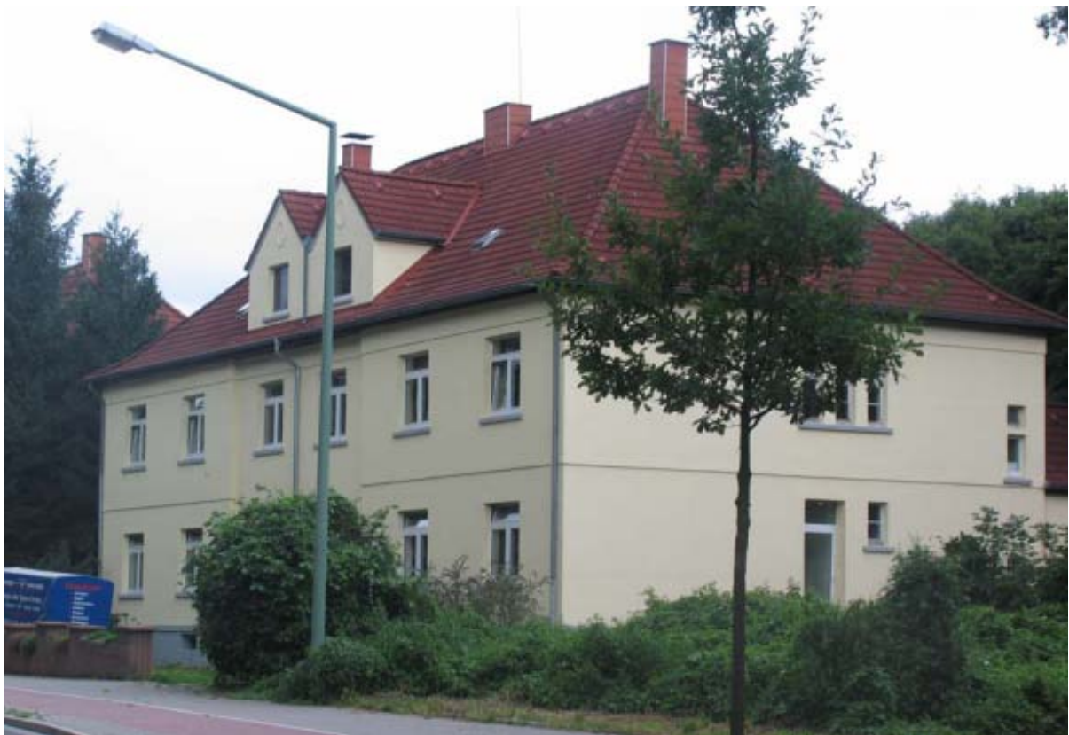
Das südliche Gebäude Haus Nr. 253 nach der Fassadensanierung
