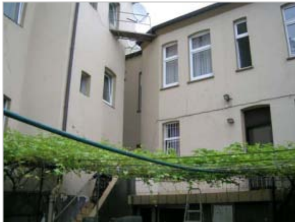
Die Wohnungen im Anbau (rechts) werden durch eine Treppenanlage (links vorne) innerhalb der Gebäudeecke erschlossen.
