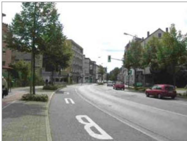
Nördliche Zufahrt Ewaldstraße am alten Friedhof
