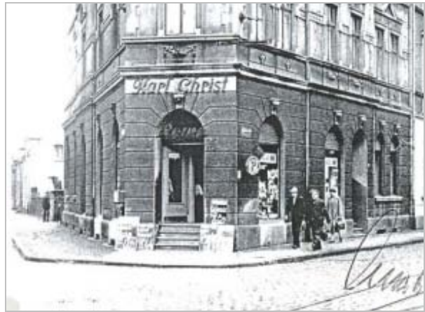
Das Foto um 1950 zeigt die noch unveränderte Erdgeschosszone aus der Zeit der Errichtung des Gebäudes um 1900 und die damalige Nutzung durch einen Lebensmittelmarkt.
