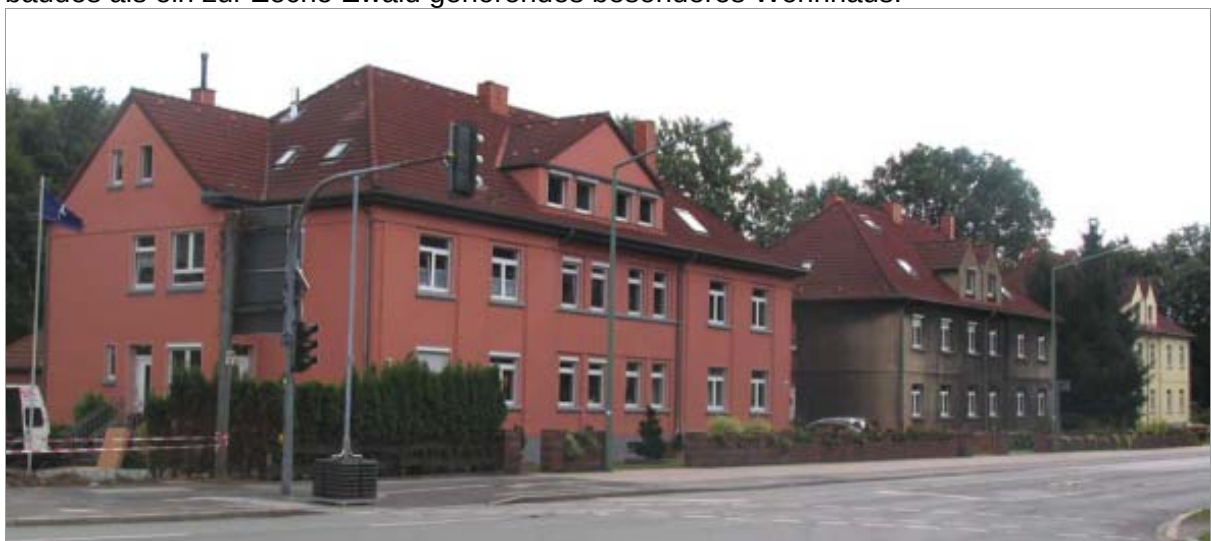
Der rötliche Farbton verfremdet die Situation sowie das Gebäude und entspricht eher einem sehr beliebigen Zeitgeist. Die vorhandene besondere Typik des Gebäudes ist unberücksichtigt geblieben.
