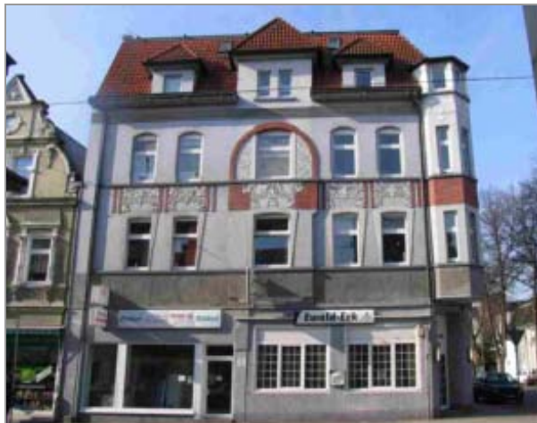
Ewaldstraße 64 (1880/98) Zwerchhaus und Turm-Eckerker
