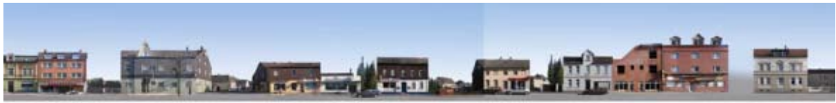
Die fotografische Abwicklung zeigt das freistehende Gebäude Ewaldstraße Nr.111 (rot unterstrichen) innerhalb der für diesen Bereich typischen offenen Bauweise auf der Ostseite der Ewaldstraße.
