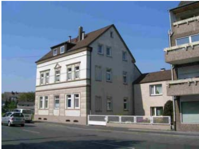
Das Gebäude Ewaldstraße 121 mit dem südlichen Anbau eines ehemaligen Werkstattgebäudes.
