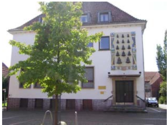
Nordansicht Glindower Platz
