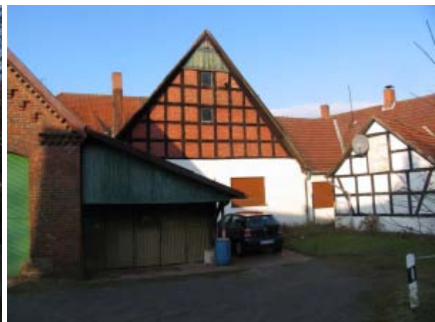
ehemaliges Wohnhaus, Innenhof
