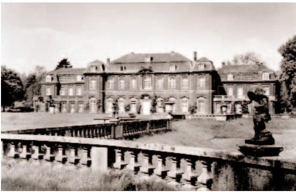
△ 12 Schloss Nordkirchen, Westgarten, Oranienburg und Balustrade von Südosten Foto WAfD 1953
