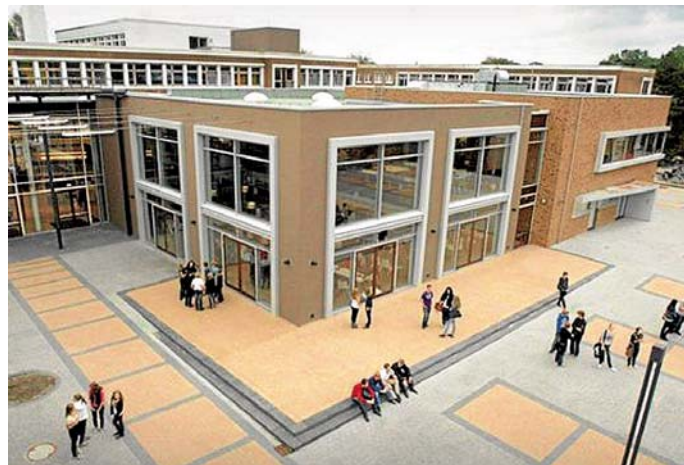
Viel Raum für die Ganztagschule: Das Kopernikus Gymnasium nach der Erweiterung durch Borowski & Sasse. Foto: Sven Rapreger
