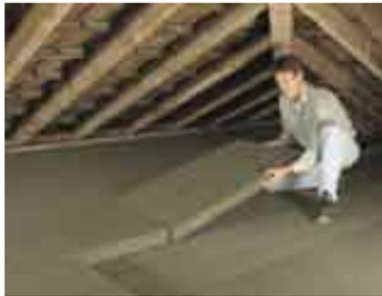
Abb. 19\_\_typischer Spitzboden, gedämmt
