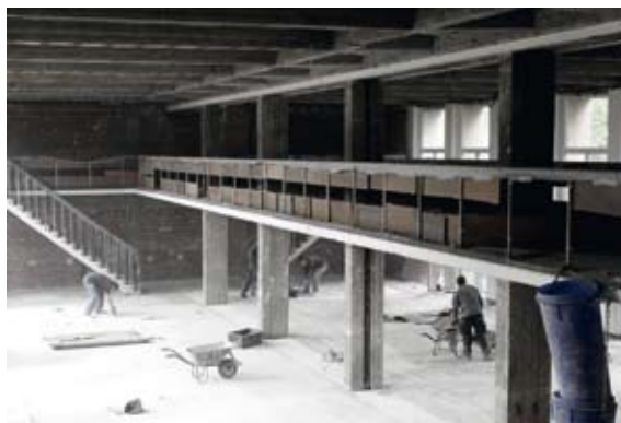
> Abbildung 5: Das RWS I nach den Abrissarbeiten
