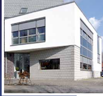
Oben: Bürogebäude Borowski & Sasse
