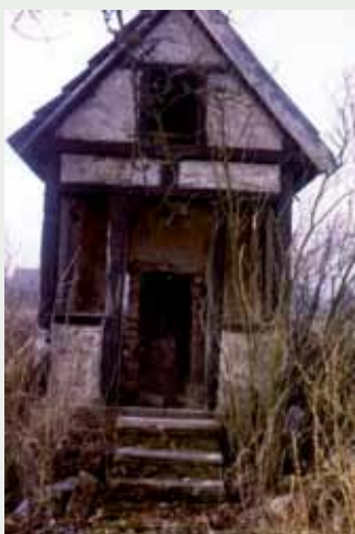
Das alte Gartenhaus 1977 kurz vor dem Abbruch
