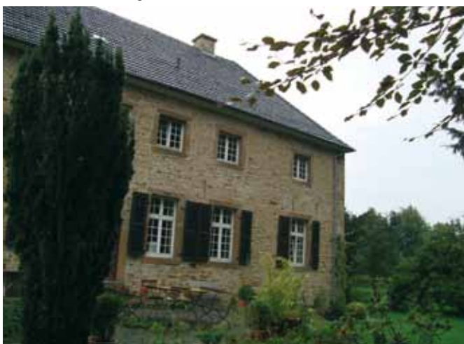
Altes Pfarrhaus Bevergern - Ansicht von Süden.
