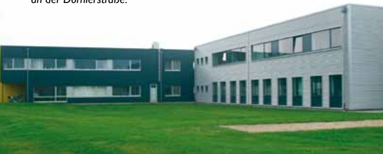
Ansicht des W+K-Bürogebäudes an der Dornierstraße.
