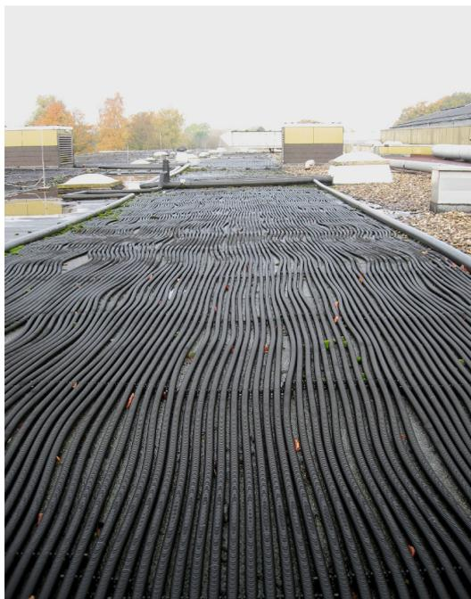
Foto: Thermische Solaranlage auf dem Dach des Aaseebades
