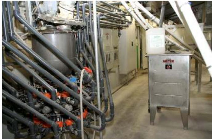
*Über einen Medikamentendosierer wurde das flüssige Fermentgetreide der Flüssigfütterungsanlage genau Zudosiert.*
