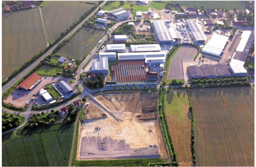
Das neue Zuhause für den Hasen Felix: Hier entsteht das neue Logistikzentrum des Coppenrath-Verlags.
