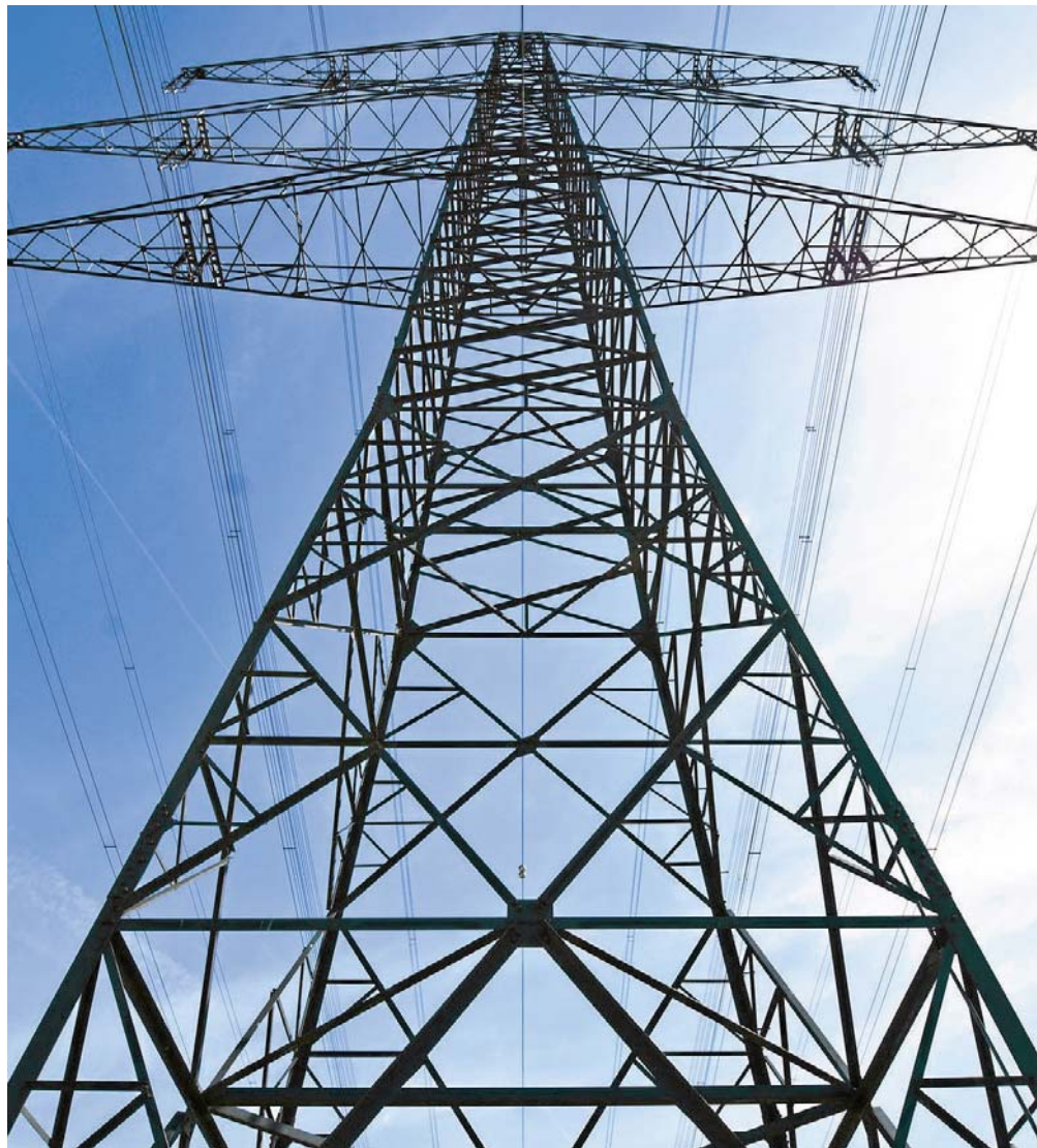
Der große „General-Planer“ ist keine Lösung für das Kapazitätsproblem auf dem Strommarkt.
