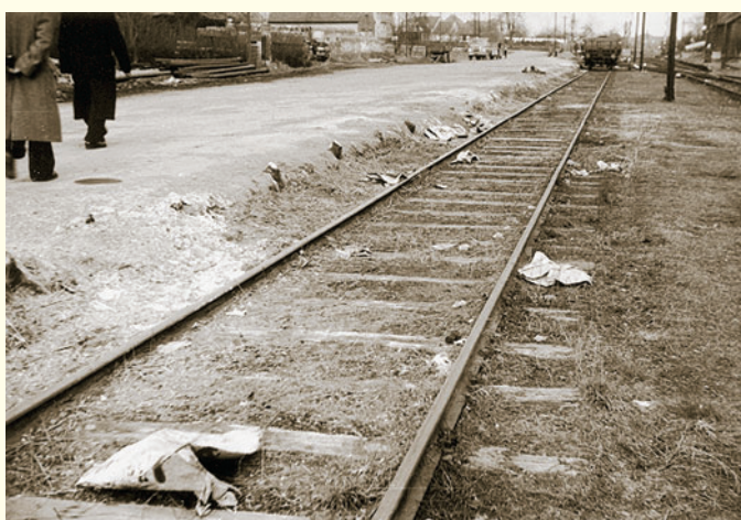
Der Bahnhof Delbrück hatte am Gleis 2 eine Ladestraße mit einer Kante aus hochgestellten Packlagesteinen und einer Teerdecke. Im Jahr 1958 war diese noch gut erhalten, allerdings die Ladestraßenkante schon stark beschädigt.
