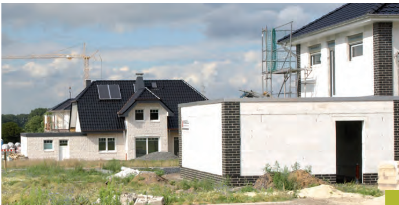
Neue Einfamilienhäuser stehen kurz vor der Fertigstellung
