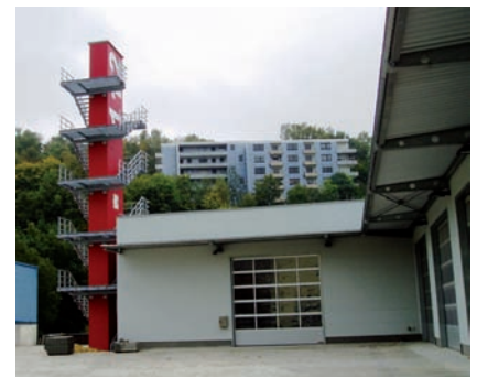
Der neue Feuerwehrturm
