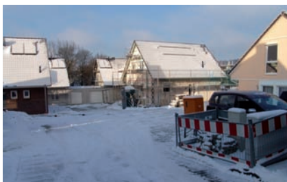
Ansicht von der Erlenstraße aus in den Innenhof
