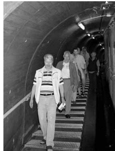
Der Heimatverein im Inneren der Heilenbecker Sperrmauer
