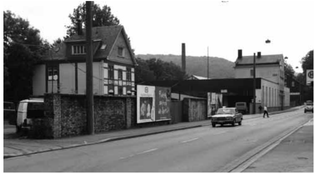
Altes Firmengelände in der Neustraße. Links die erste Verwaltung und rechts die Wagenhalle
