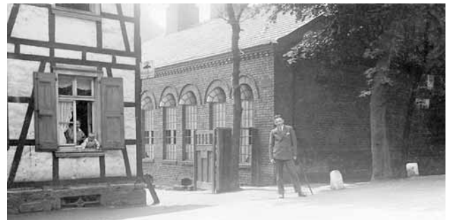
Alter Zugang zum Firmengelände
