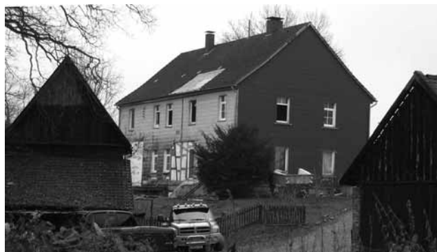
Fachwerkhaus Schweflinghausen 32 nach dem Brand
