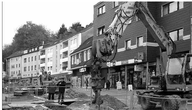
Bauarbeiten in der FUZO
