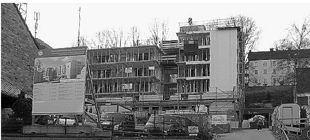
Das Altenheim wird auf den neuesten Stand gebracht
