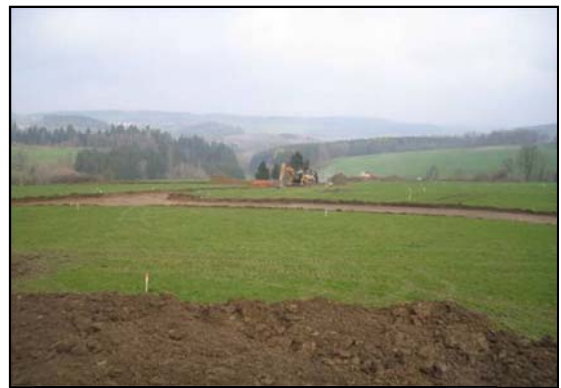
Mit der Herstellung der Baustraße wurde begonnen. Die Grundstücke und die Straßentrasse sind vermessen und abgesteckt.
