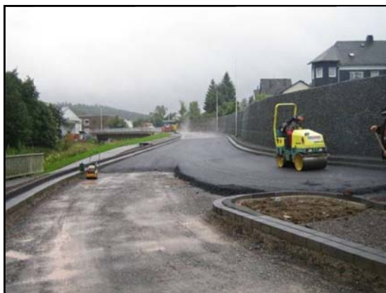
Die Fahrbahn wird asphaltiert.
