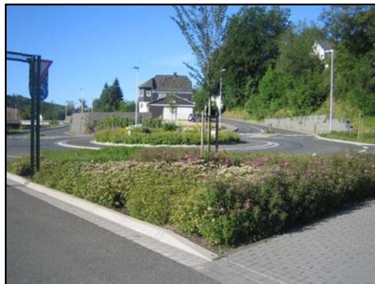
Der Kreisverkehrsplatz ist fertig gestellt. Zu sehen sind die vier Einmündungen zur Biggestraße, zur Stellwerkstraße und zum ebenfalls fertig gestellten Parkplatz.
