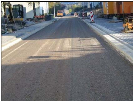
Die Gehwege sind gepflastert. Die Fahrbahn „wartet“ auf die Asphaltbetondecken.
