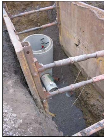
Der Mischwasserkanal in der „Fritz-Reuter-Straße“ wird erneuert.
