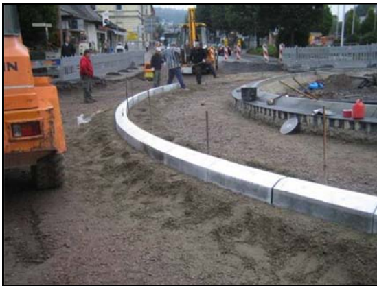
Der Kreis im Bau.
