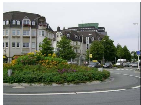
Der fertig gestellte Kreisverkehrsplatz.
