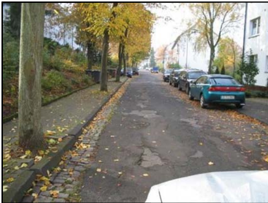
Die „Fritz-Reuter-Straße“ vor dem Ausbau.
