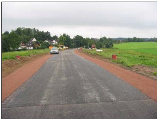
Die Baustraße ist fertig. Die Fahrbahn ist in Asphaltbauweise und die Gehwege sind in einer wassergebundenen Decke hergestellt worden.
