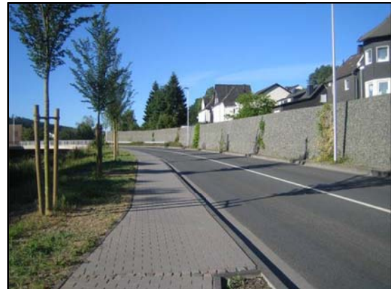
Die fertige Gabionenwand mit
