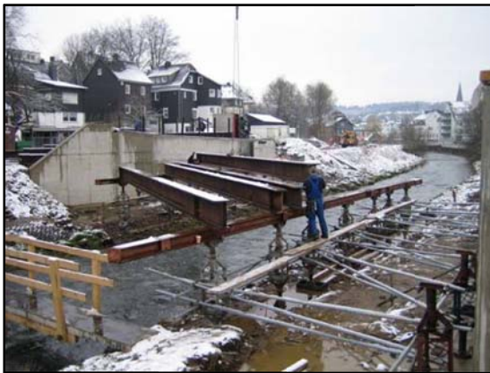
Aufbau des Traggerüsts
