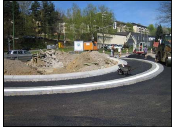
Der Kreisverkehrsplatz ist bereits zu erkennen.
