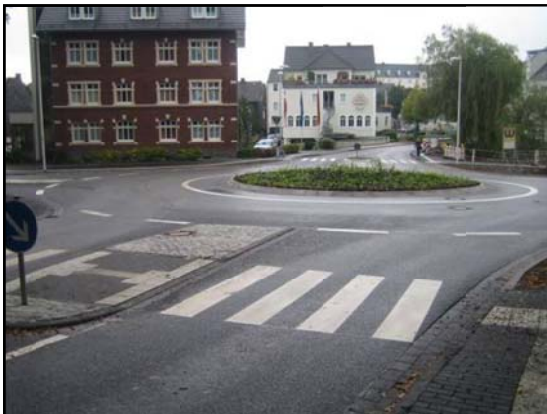
Der Kreisverkehrsplatz unmittelbar nach Verkehrsfreigabe.
