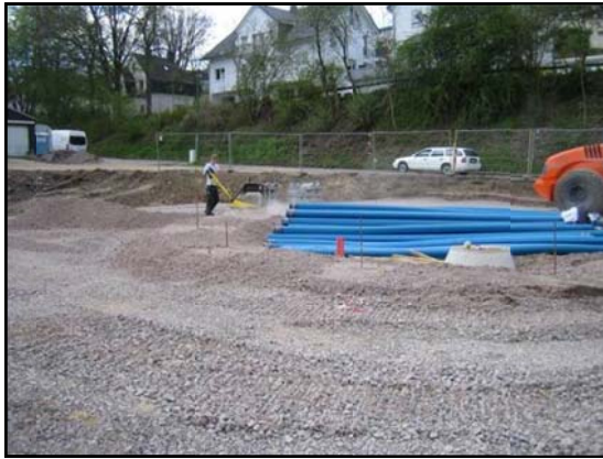
Mit dem Bau des Kreisel „Biggestraße“ wurde begonnen.
