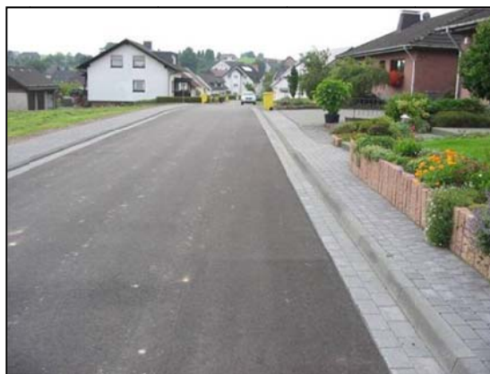
Die Straße „Auf der Ennert“ im endausgebauten Zustand.
