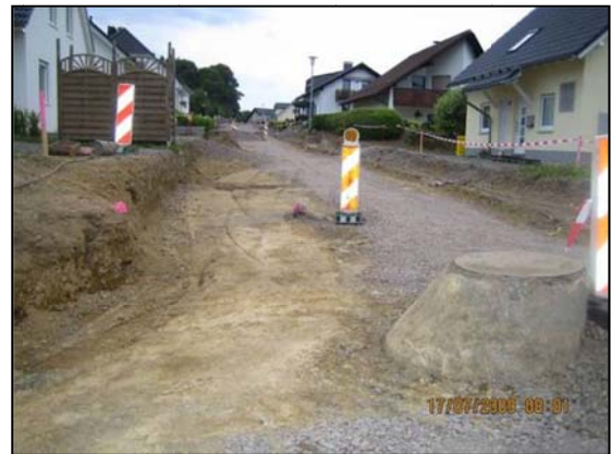
Die Straße „Auf der Ennert“ während dem Endausbau.
