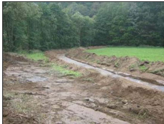
Abbruch der Wehranlage und Umgestaltung des Olpebaches
