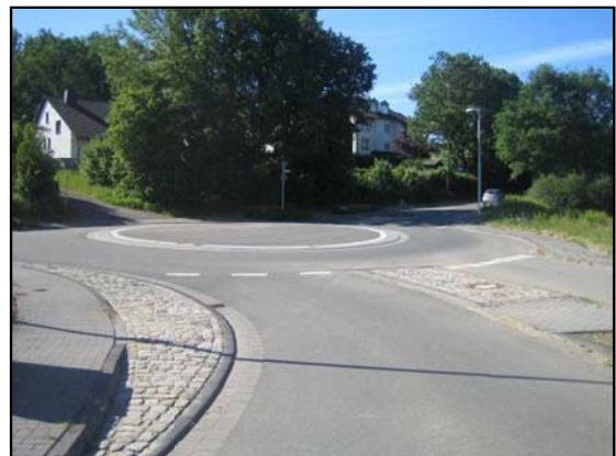
Der Kreisverkehrsplatz ist hergestellt. Im Vordergrund die fertig gestellte Zufahrt zum Neubaugebiet.
