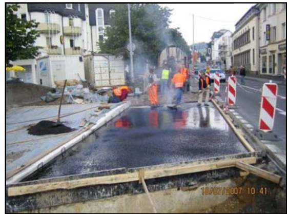
Die Brücke über die Olpe wird ebenfalls saniert.
