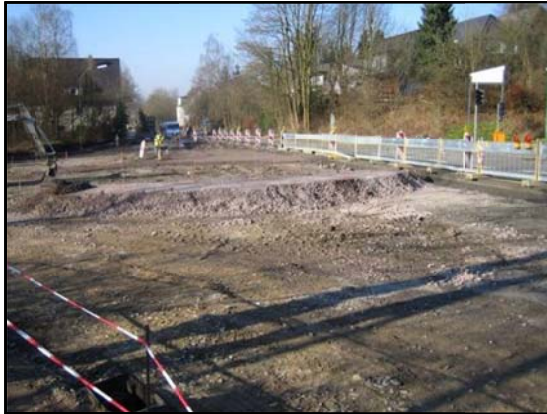
Hier soll ein Kreisverkehrsplatz entstehen.
