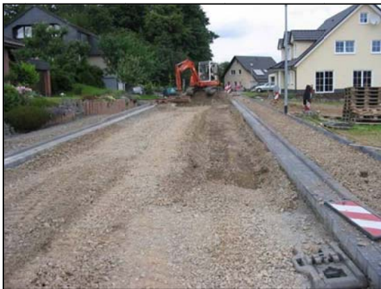
Endausbau der Straße „Auf der Ennert“, 2. BA
