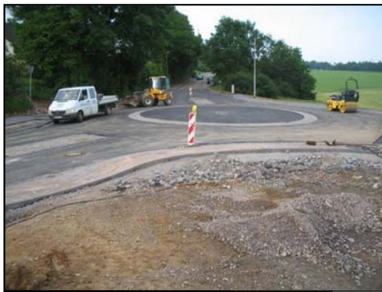
Bau des Kreisverkehrsplatzes „Am Bratzkopf“
