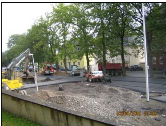
Provisorische Anbindung des Kreisverkehrsplatzes an die Straße „Am Biggeufer“
