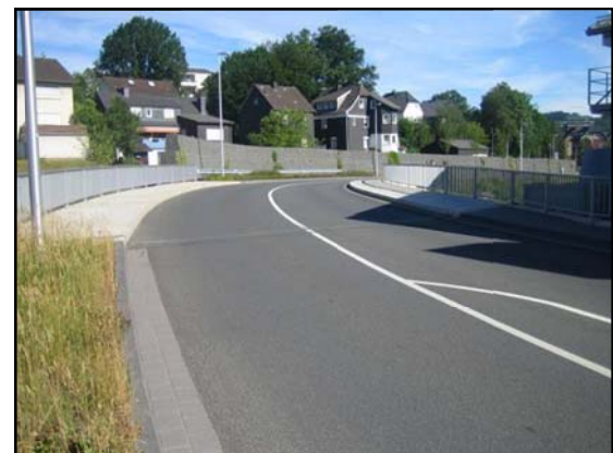
Die fertig gestellte Stellwerkstraße mit Brücke und Gabionenwand als Lärmschutzwand im Hintergrund.
