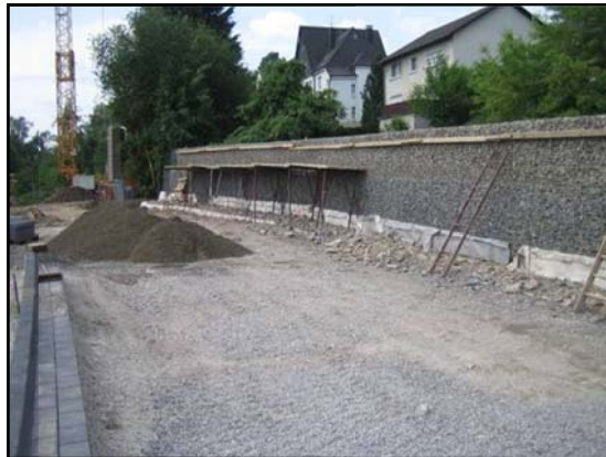
Die Gabionenwand (Lärmschutzwand) an der „Stellwerkstraße“ entsteht.
