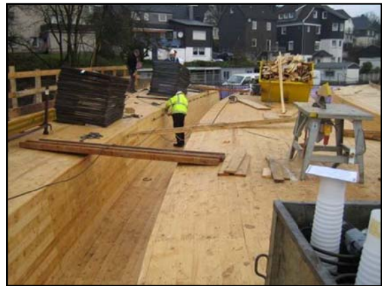
Die Brücke wird eingeschalt.
