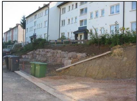
Die Parkplätze, die in Zusammenarbeit mit der Wohnungsgenossenschaft errichtet werden, sind in Bau.
