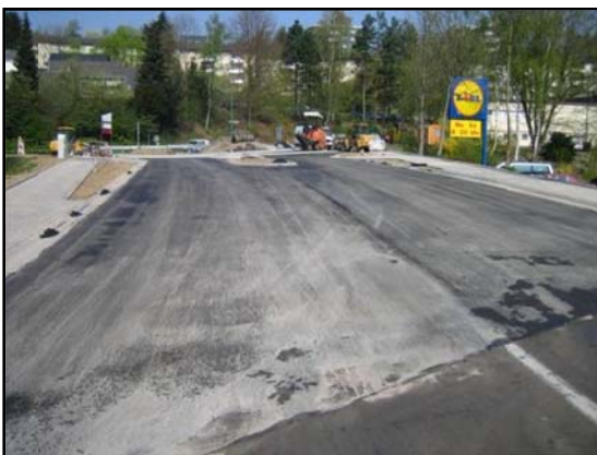
Der Kreis in Bau aus Richtung „Bilsteiner Straße“.
