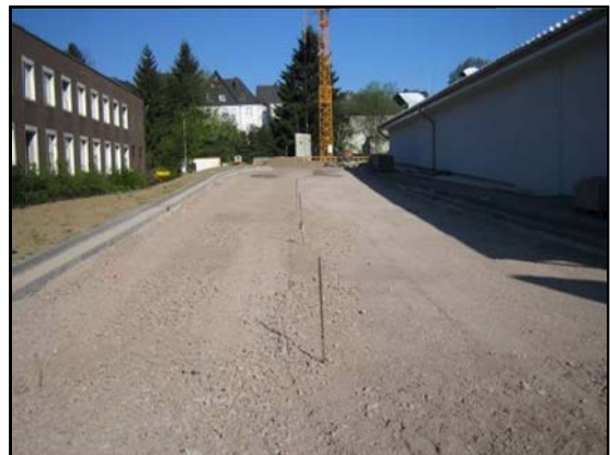
Die Frostschuttschicht ist eingebaut.
