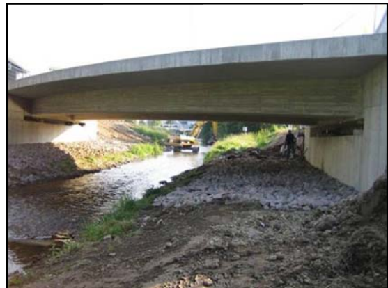
Die Betonarbeiten sind abgeschlossen.
