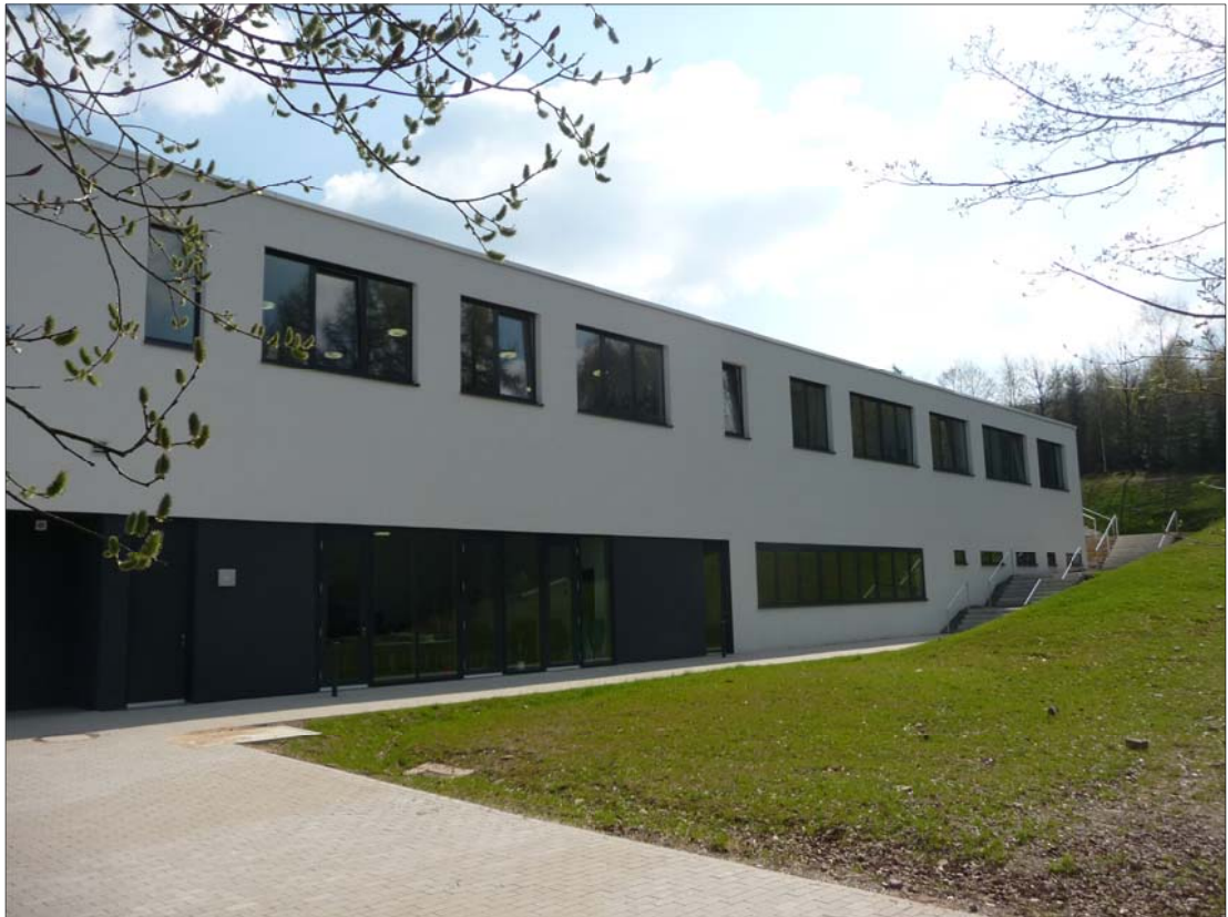
Hauptschule Hakemicke, Neubau Gebäude I
