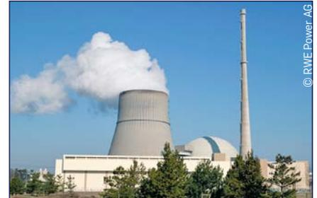
1400 MW Kernkraftwerk mit Leichtwasserreaktor der Konvoi-Baureihe,
