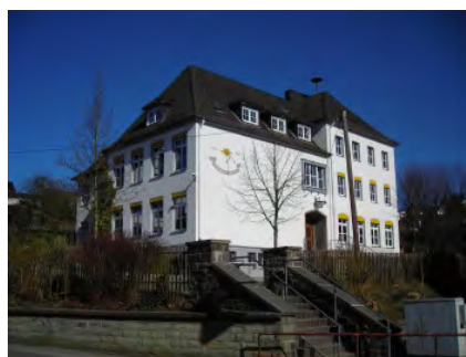
Kath. Grundschule Rönkhausen
