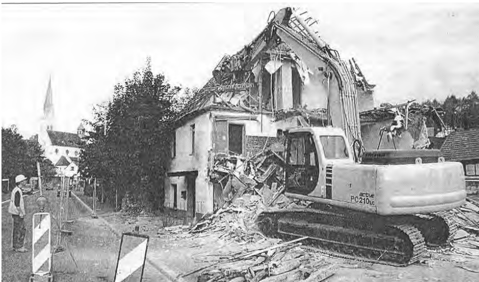
Abbrucharbeiten Haus „Hauptstraße 52“
