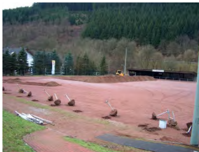
Endlich Baubeginn - April 2006
