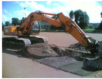
Der Bagger rollt – August 2006
