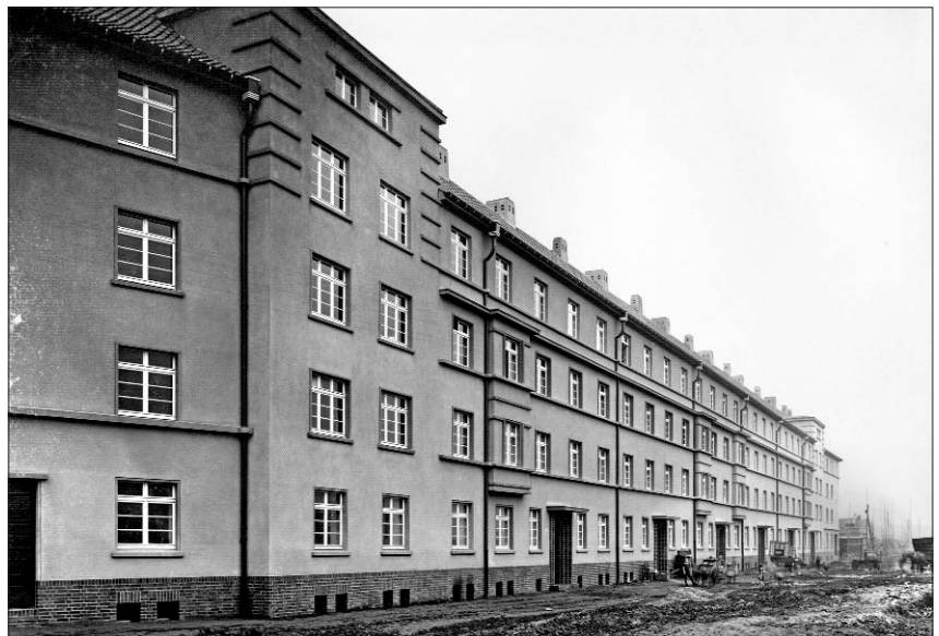
Dortmund, Innenstadt-West: Neu errichteter Wohnblock, Von-der-Recke-Straße, 1928
