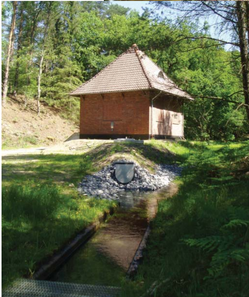
Bild 5: Pumpstation des WW 05 der Stadtwerke Bielefeld im Bärenbachtal / Kreis Gütersloh
