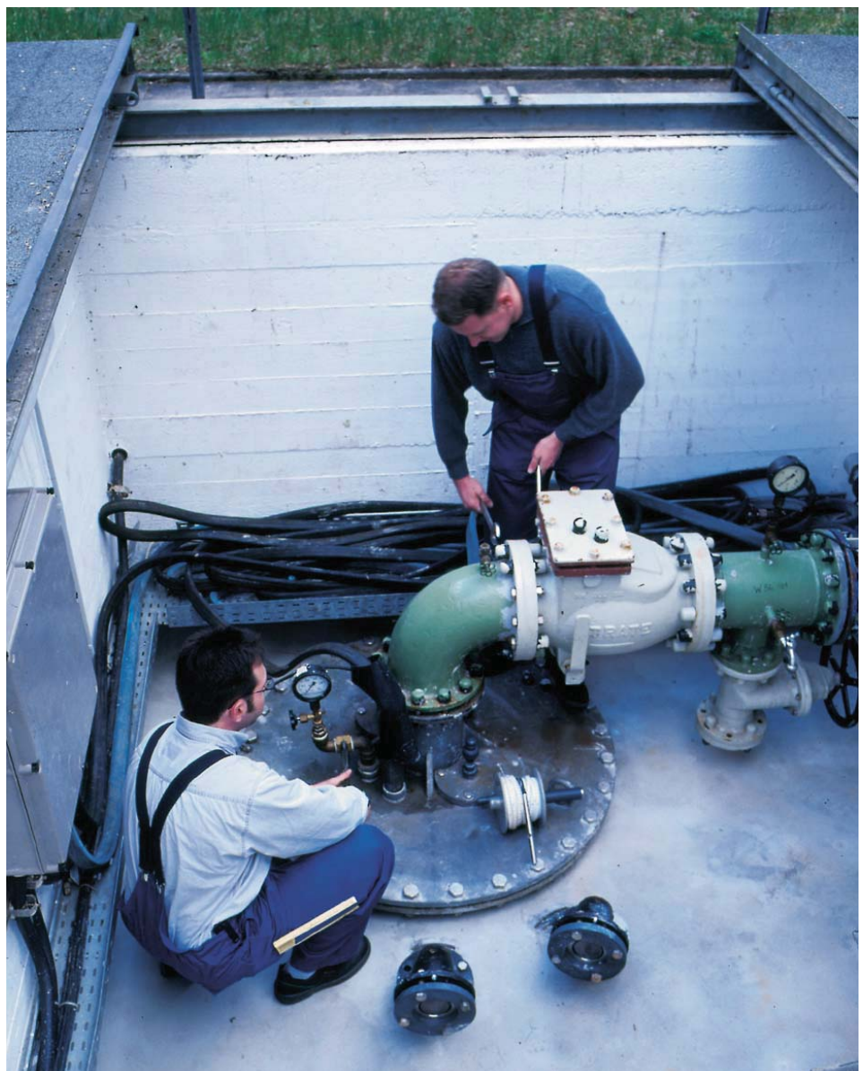
Bild 7: Reparaturarbeiten am TB 6 der Stadtwerke Bielefeld
