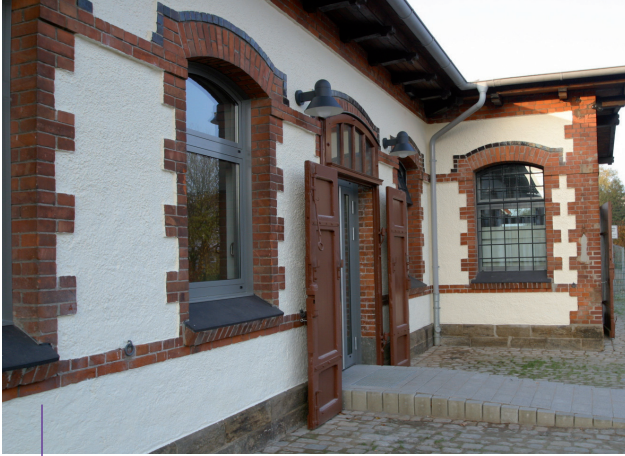
Die ehemalige Hufschmiede auf dem Campus Minden wurde renoviert und wird jetzt für die Lehre genutzt.
