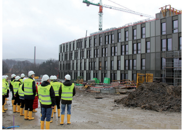
85 Prozent des Betons und des Stahls sind am FH-Neubau im Januar verbaut. Auch erste Fassadenelemente wurden bereits montiert.
