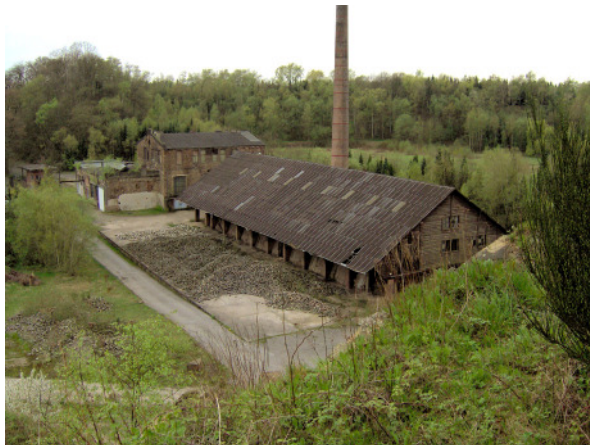
Abb. 1: Hoffmannscher Ringofen zum Brennen der Ziegel (04/2005, T. KASIELKE).
