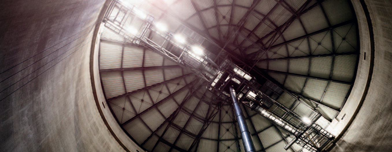
Trianel Kohlekraftwerk Lünen – Dachkonstruktion des Kohlesilos
