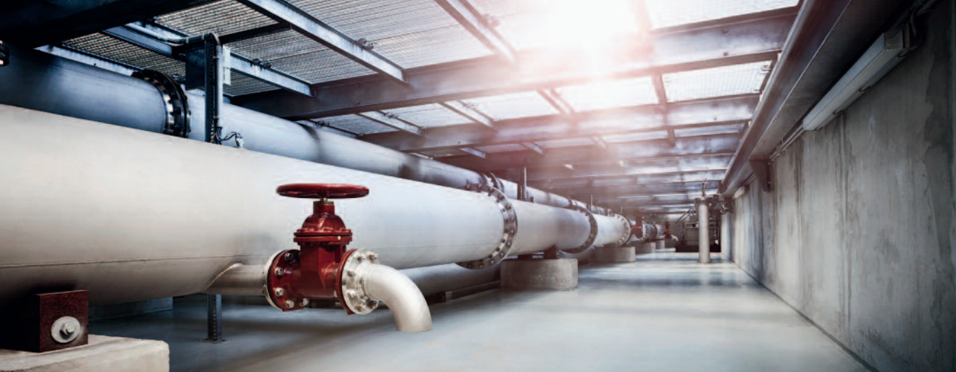
Verbund-Wasserwerk Witten – Verrohrung des Filtratablaufs
