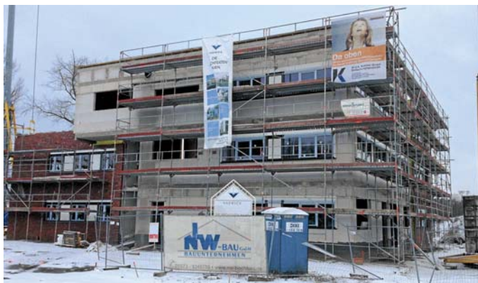
Im Bau: Auf dem Steinfurter Campus der FH Münster entsteht derzeit GRIPS III. Im Juni soll das Gebäude fertig sein. Foto: privat
