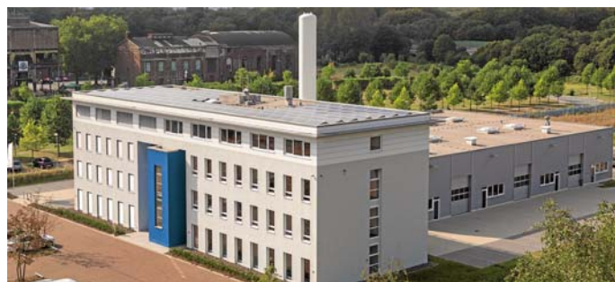
Im kerzenförmigen Tank hinter dem Anwenderzentrum wird die in Wasserstoff umgewandelte Windenergie gespeichert. Foto: B. Berkau
