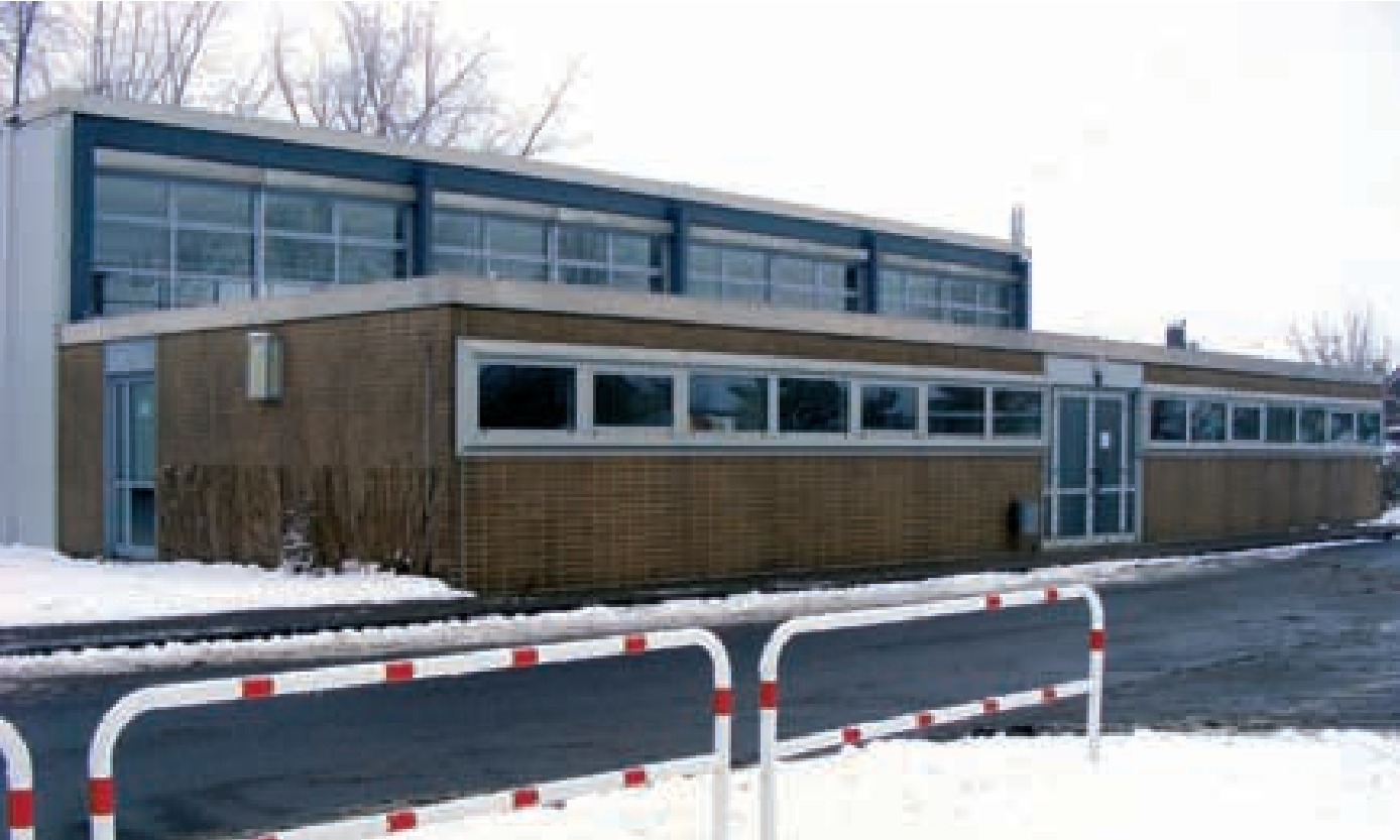
Ein kleiner Zettel an der Eingangstür (siehe unten) zeigt an: Zu viel Schnee, bitte draußen bleiben. Die Decke könnte von der Decke rieseln und deshalb gilt: Bis Mitte nächster Woche kein Sport in der Walstedder Sporthalle. Fotos (2): dz
