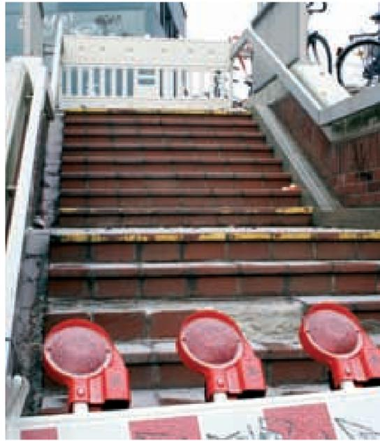
**Gefährlich:** Weil der Frost der Treppenanlage am Hausbahnsteig arg zugesetzt hat, musste sie nun gesperrt werden. Sobald das Wetter es zulässt, soll die Treppenanlage ausgebessert werden. Foto: dz
