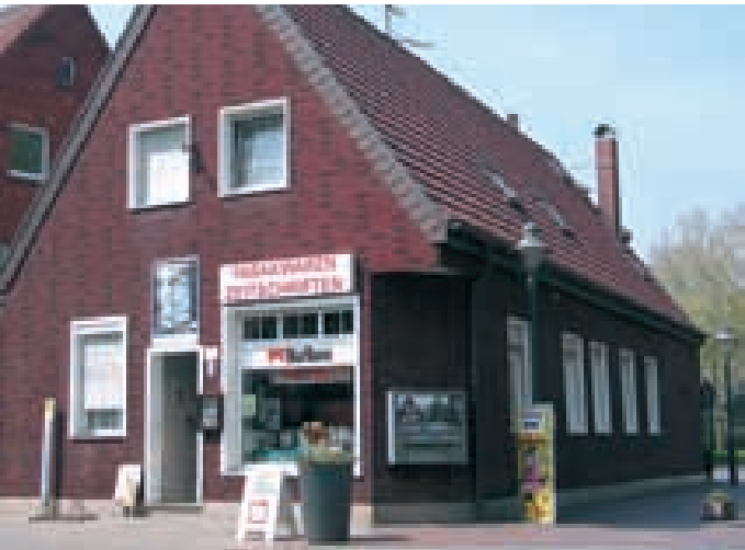
Im Eckhaus Mühlenstraße/Wagenfeldstraße wurden früher einmal Schweine geschlachtet.
