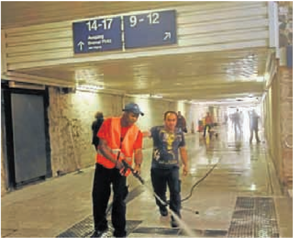
Zwar wird hier noch sauber gemacht, „neu“ sieht der Tunnel aber nicht aus.
