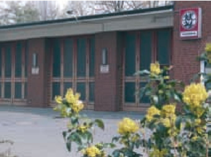
Der Standort der Feuerwache an der Sendenhorster Stra- ße steht zur Debatte. Die Stadtverwaltung hat bereits einen Alternativstandort an der Konrad-Adenauer-Straße gegen- über des Möbelhauses Gaßmüller ins Auge gefasst. Foto:ne
