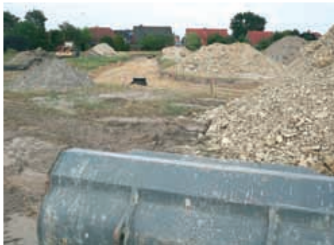
Die Arbeiten im neuen Baugebiet Berthas Halde haben vor kurzem begonnen.
