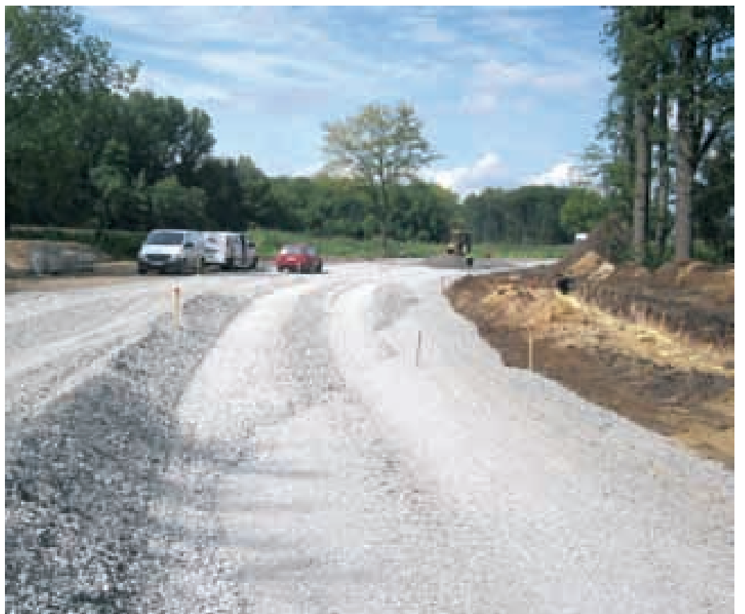
Auf der K4 zwischen Sendenhorst und Ahlen laufen seit Juli die Arbeiten für den letzten Ausbaubauabschnitt. Die Strecke ist auf 500 Metern voll gesperrt.
