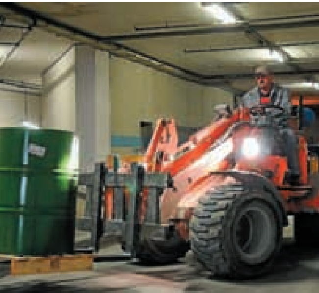
Die Sanierungsarbeiten im Theater-Parkhaus gehen in die Endphase. Bis September soll alles fertig sein. Foto Etkorn
