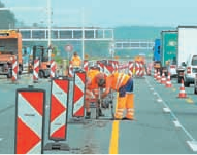
Markierungsarbeiten: Gestern wurde auf der Autobahn 1 im Kreuz Münster-Süd eine Baustelle eingerichtet. Foto Etkorn
