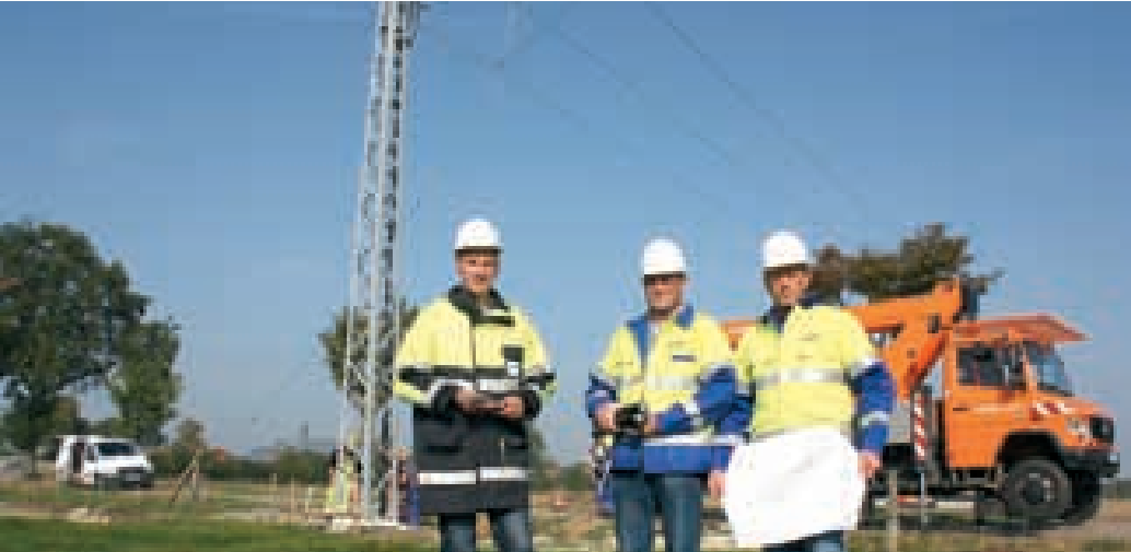
Die Überland-Leitung wird durch ein Erdkabel ersetzt. Das Bild zeigt (v.l.) die RWE-Mitarbeiter Paul Meimann mit einem Stück des 70 Quadratmillimeter dicken Überland-Leitungskabels, Heinz Feder mit einem Stück des 500 Quadratmillimeter dicken neuen Kabels und Norbert Siemann mit einem Plan der Kabel-Arbeiten. Foto: dz
