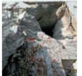
Durch die Fehlsprengung wurde ein dickes Loch in die Bunkerwand gerissen. Foto RED
