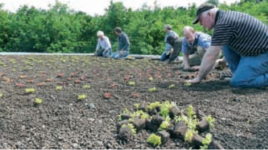
Pflanzen im Akkord: 5000 Sedumpflanzen setzten 20 Pfadfinder und Helfer der RWE am vergangenen Wochenende auf die Dächer des Jugendgästehauses. Foto: pr
