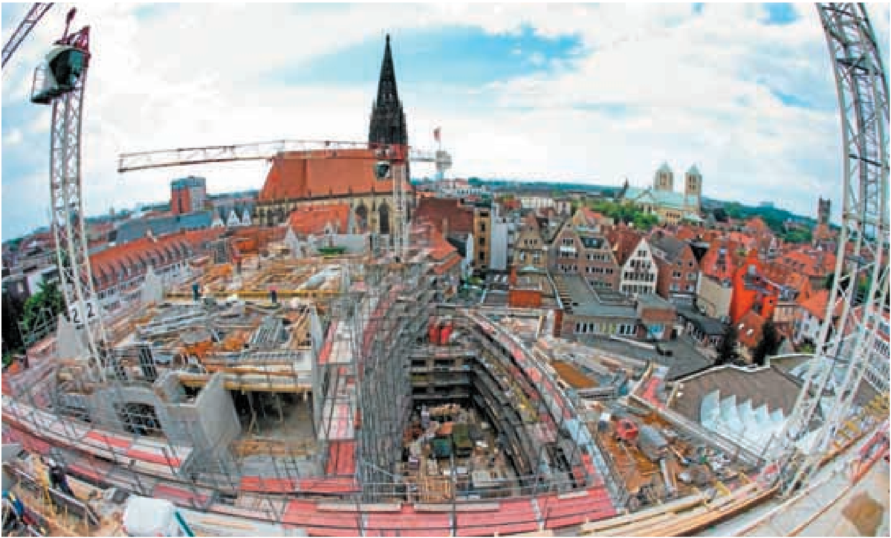
Der neue Alte Fischmarkt ist ausgewachsen: Von der Spitze des Eckhauses kann man beinahe auf Augenhöhe zum Turmer von St. Lamberti hinübergrüßen: Der Rohbau des neuen Gebäudekomplexes am Alten Fischmarkt ist so gut wie fertig. Gestern wurde nach acht Monaten der erste der drei großen Baukräne demontiert, bis Anfang August sollen die beiden anderen folgen. Aus dieser Perspektive gut zu erkennen sind die fünf neuen Giebelhäuser (l.) und der ovale Innenhof (M.). Er wird öffentlich zugänglich sein, wenn das 40-Millionen-Euro-Projekt der Investorenfamilie Lohmann im kommenden Frühjahr fertig ist. Die ersten Läden sollen schon Ende 2012 eröffnen. Foto Münsterview.de
