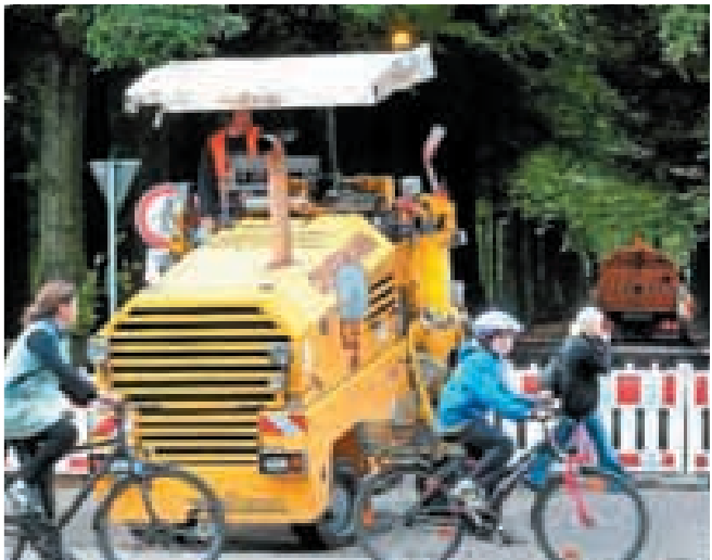
Wegen Straßenbauarbeiten ist die Promenade seit Montag für Radfahrer und Fußgänger gesperrt. Foto Etkorn
