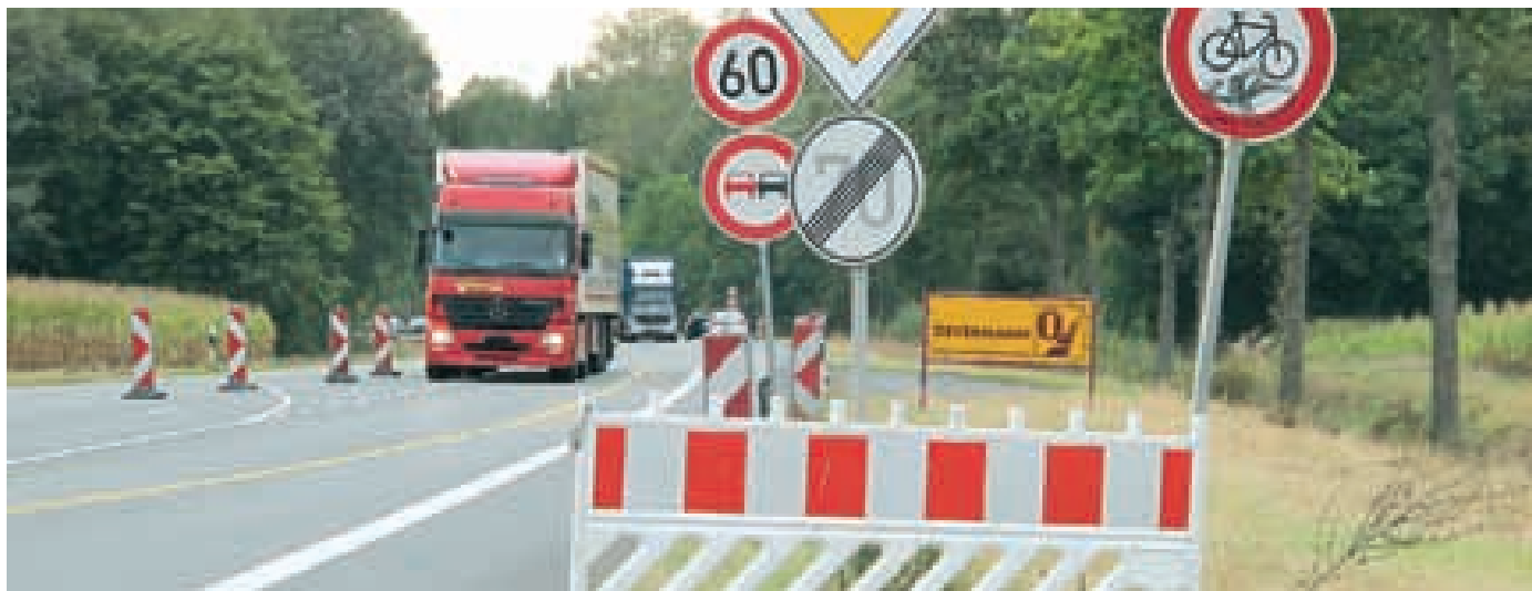
Die Baustelle auf der B58 ist eingerichtet. Hier ist derzeit nur Tempo 60 erlaubt.
