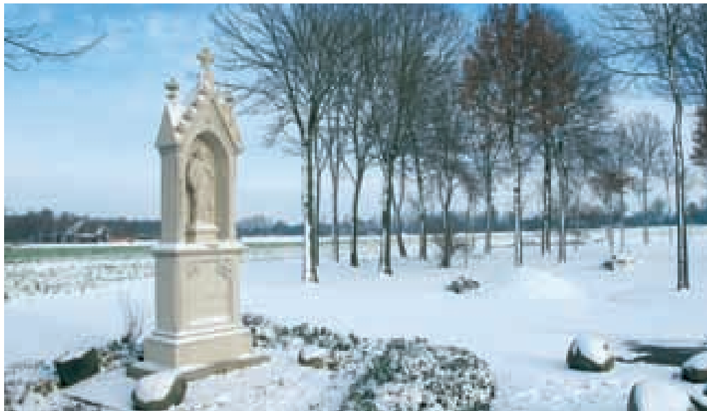
Das klare Licht eines sonnigen Wintertags lässt den über 100 Jahre alten Bildstock am Hof Osthues besonders gut zur Geltung kommen. Im Rahmen eines kreisweiten Rettungsprogramms wurde dieser im Herbst grundlegend saniert.
