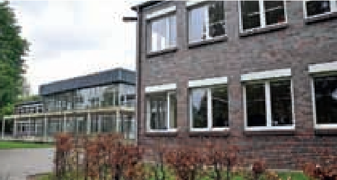
Die Aula der Hauptschule in Herbern kann nach Umbauarbeiten als Versammlungsort genutzt werden. Foto: dz
