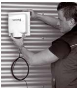
Antennenv Verstärker erhöhen die Übertragungsraten.
