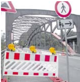
Die Prinzbrücke steht unter Denkmalschutz. Foto (A) Schneider
