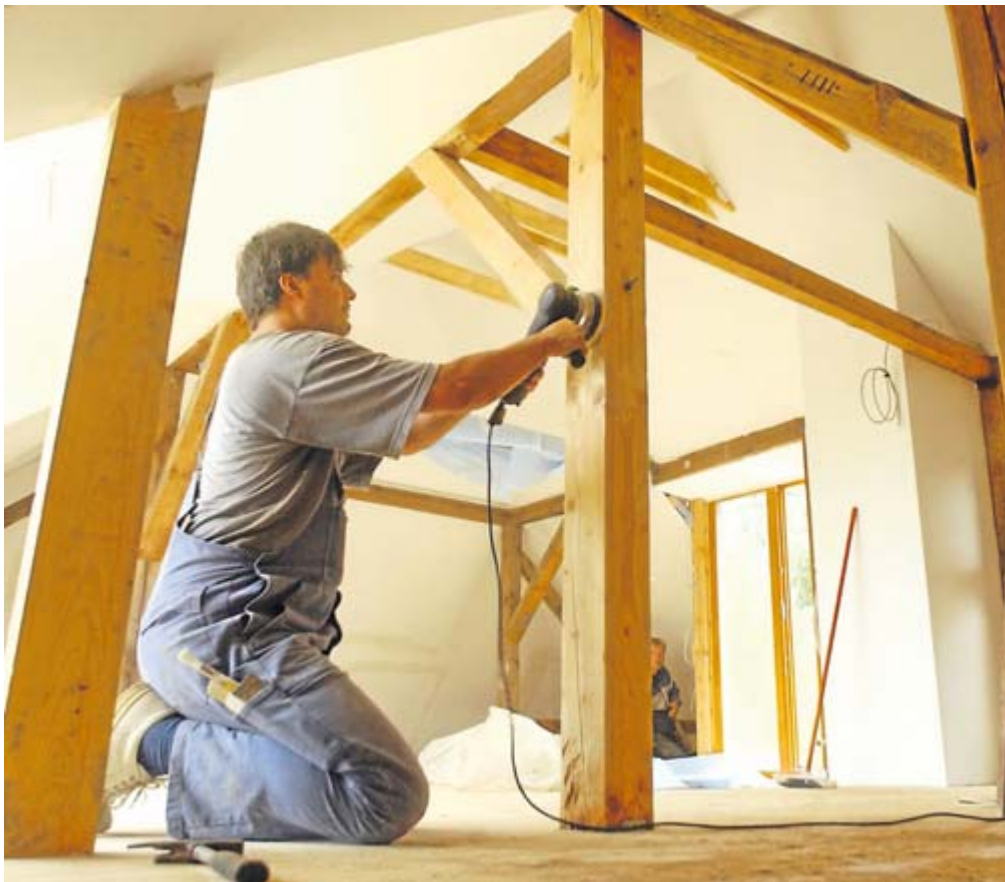
Sollen nur einzelne Dachräume ausgebaut werden, ist das oft genehmigungsfrei. Sicherheitshalber sollte man sich aber beim zuständigen Bauamt erkundigen. Foto Bauherren-Schutzbund/dapd
